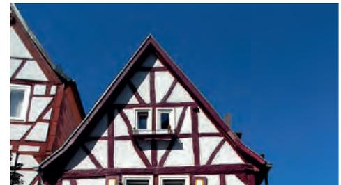
Abb. 54 Satteldach mit Aufschiebling
