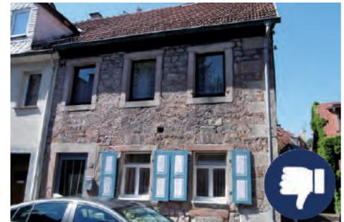
Abb. 106 Geschossweise Verwendung von Fensterläden sollte vermieden werden
