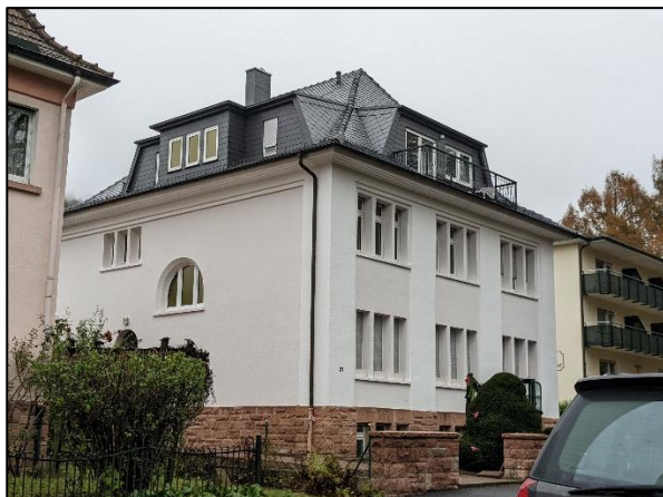
Abb. 8: Denkmalgeschütztes Gebäude in der Kurparkstraße 29 (11/2024)
