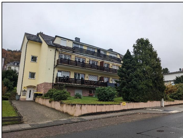
Abb. 14: Wohngebäude Jahnstraße 23 sowie 25 und gärtnerisch gepflegte Anlagen mit großkronigen Koniferen (11/2024)
